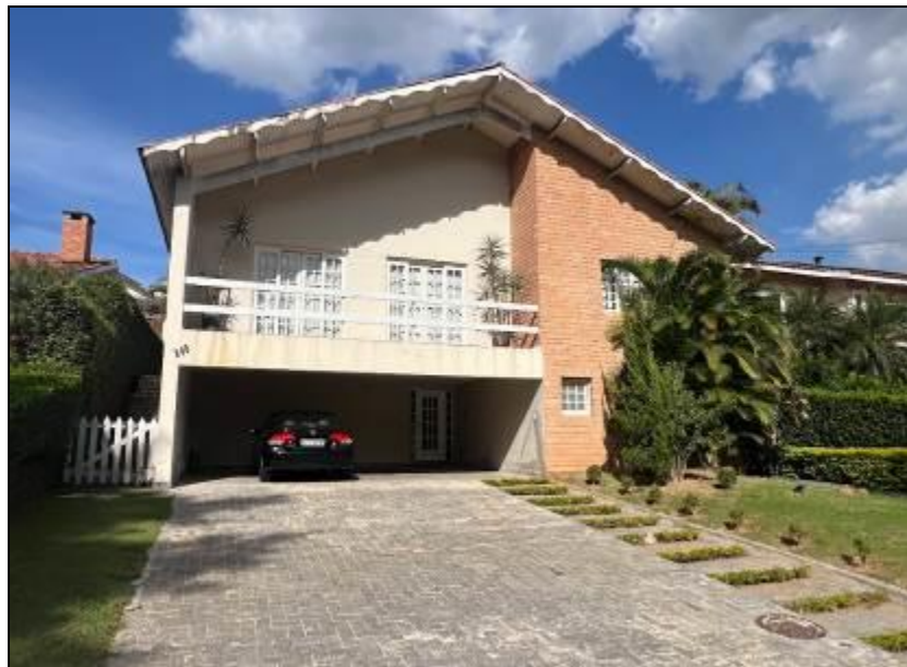
Vista do imóvel avaliando.
