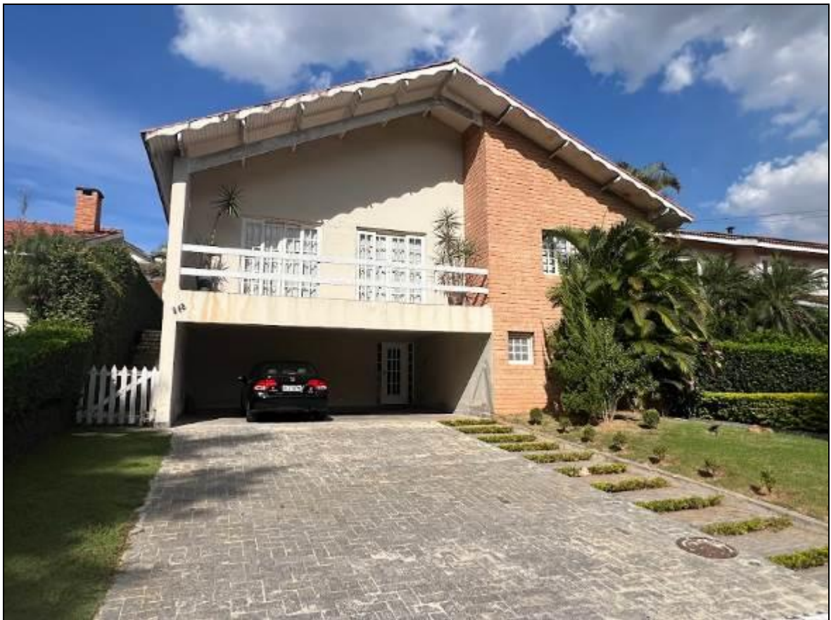
Vista da fachada do imóvel avaliando.
