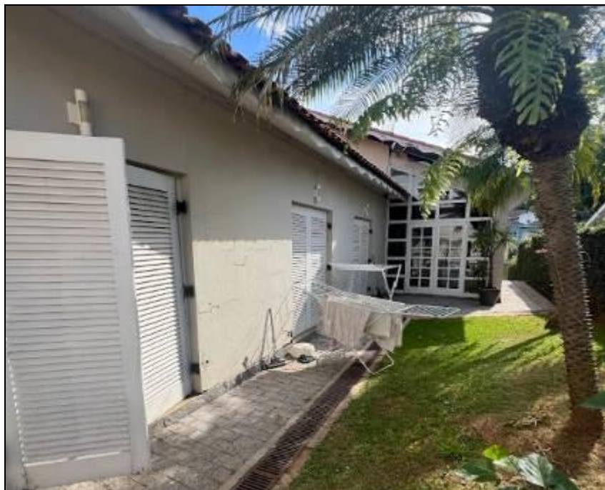
Vista da área externa.
