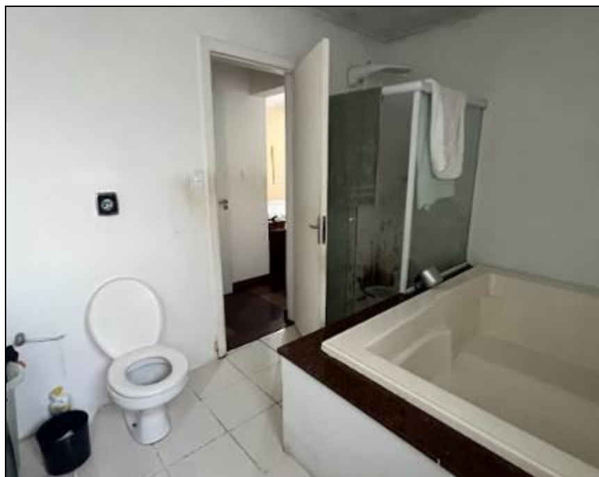
Vista do banheiro da suíte principal.
