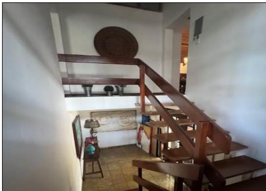
Vista da escada que dá acesso ao piso superior.
