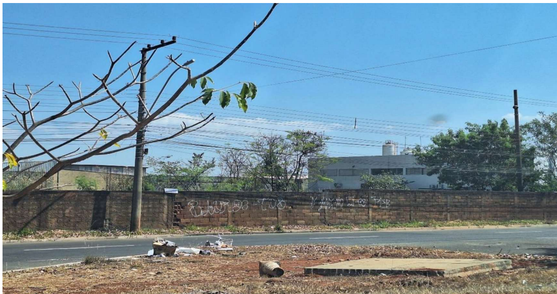
Vista externa – lotes 10 a 200 (não é possível identificar o lote 190)
