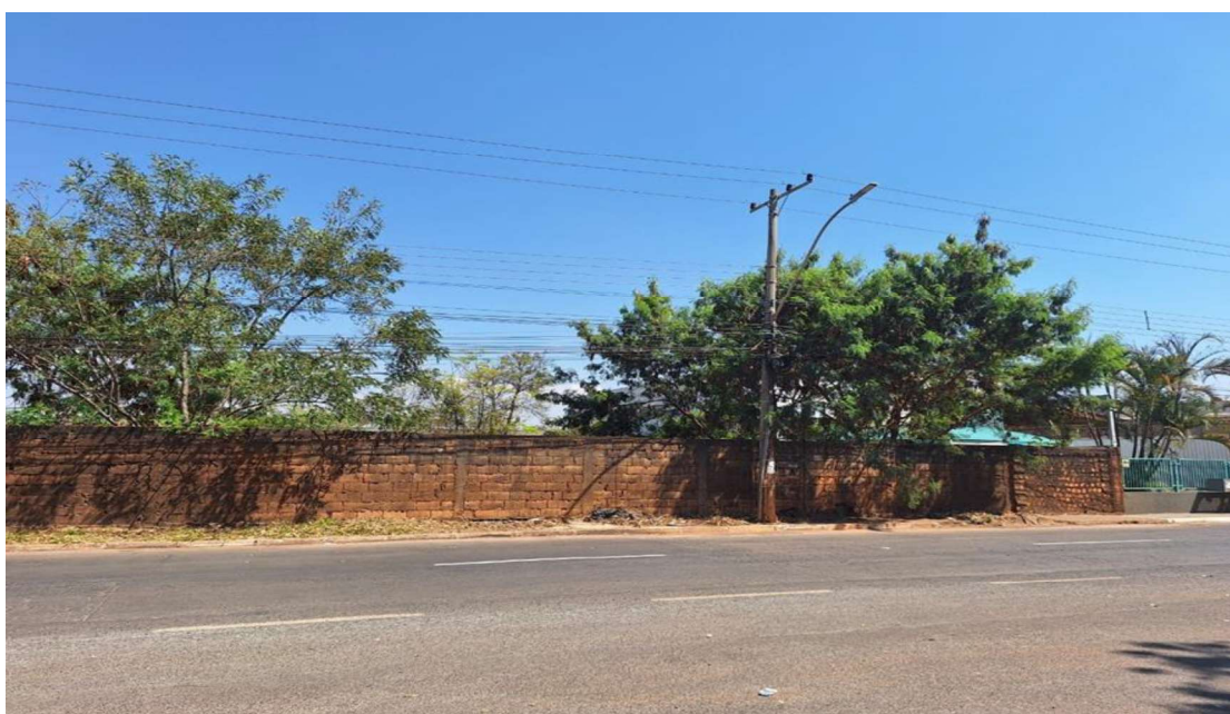
Vista externa – lotes 10 a 200 (não é possível identificar o lote 190)
