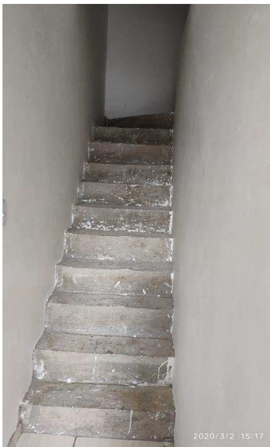
Entrada para o imóvel 03
