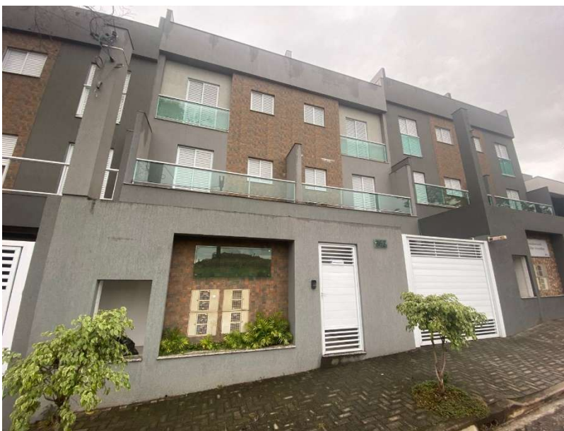
Figura 2- Vista da fachada do Residencial Magdalena Arantes observada da Rua das Azaléas
