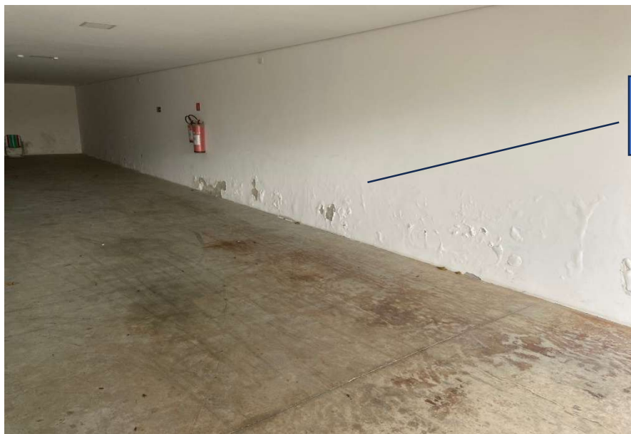
Figura 7- Vista da Garagem do Residencial Magdalena Arantes – piso térreo- com destaque para infiltrações generalizadas
