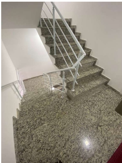
Figura 9- Vista da escada de acesso às casas revestida com granito polido cinza.
