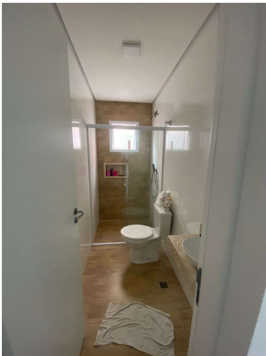
Figura 17- Vista do banheiro da casa revestido com cerâmica no piso e parede do box e pintura tipo epóxi nas demais paredes
