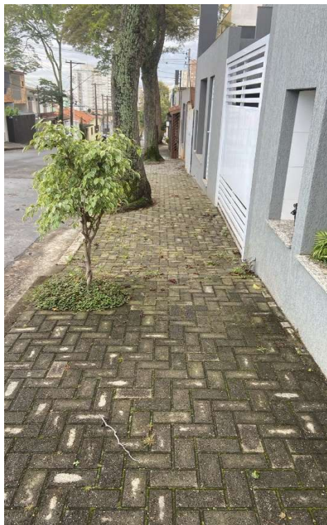
Figura 5- Vista da calçada do Residencial Magdalena Arantes
