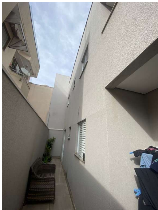
Figura 11- Vista do terraço da sala com destaque para o revestimento da fachada posterior pintada com textura cinza.
