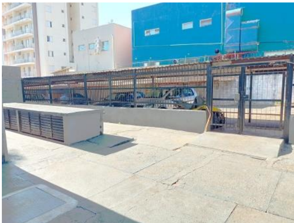
FOTO 3 Vista externa das garagens
