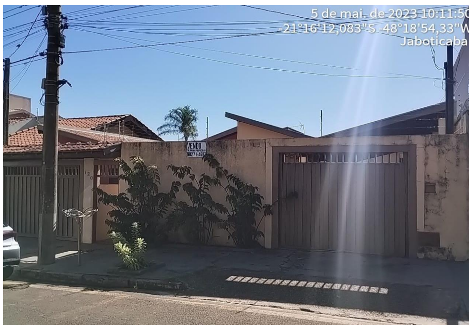
Figura 2 Vista do imóvel avaliando
