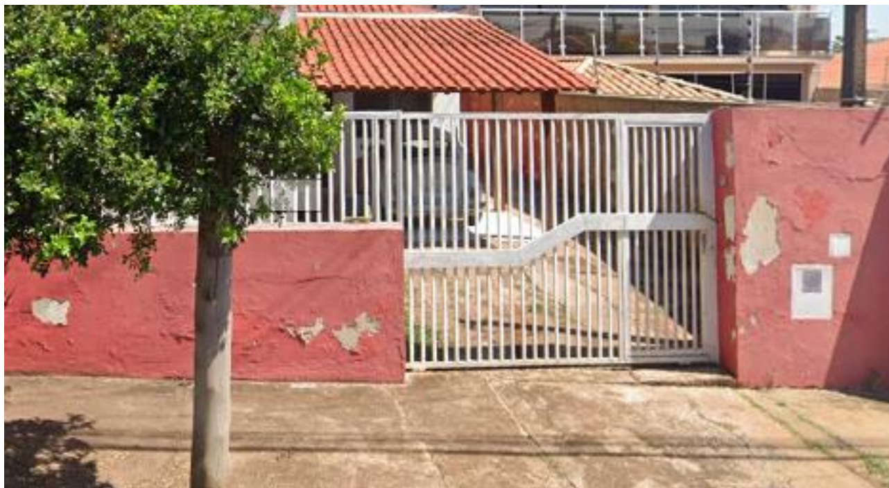
FOTO 01 – Vista geral da frente do imóvel
