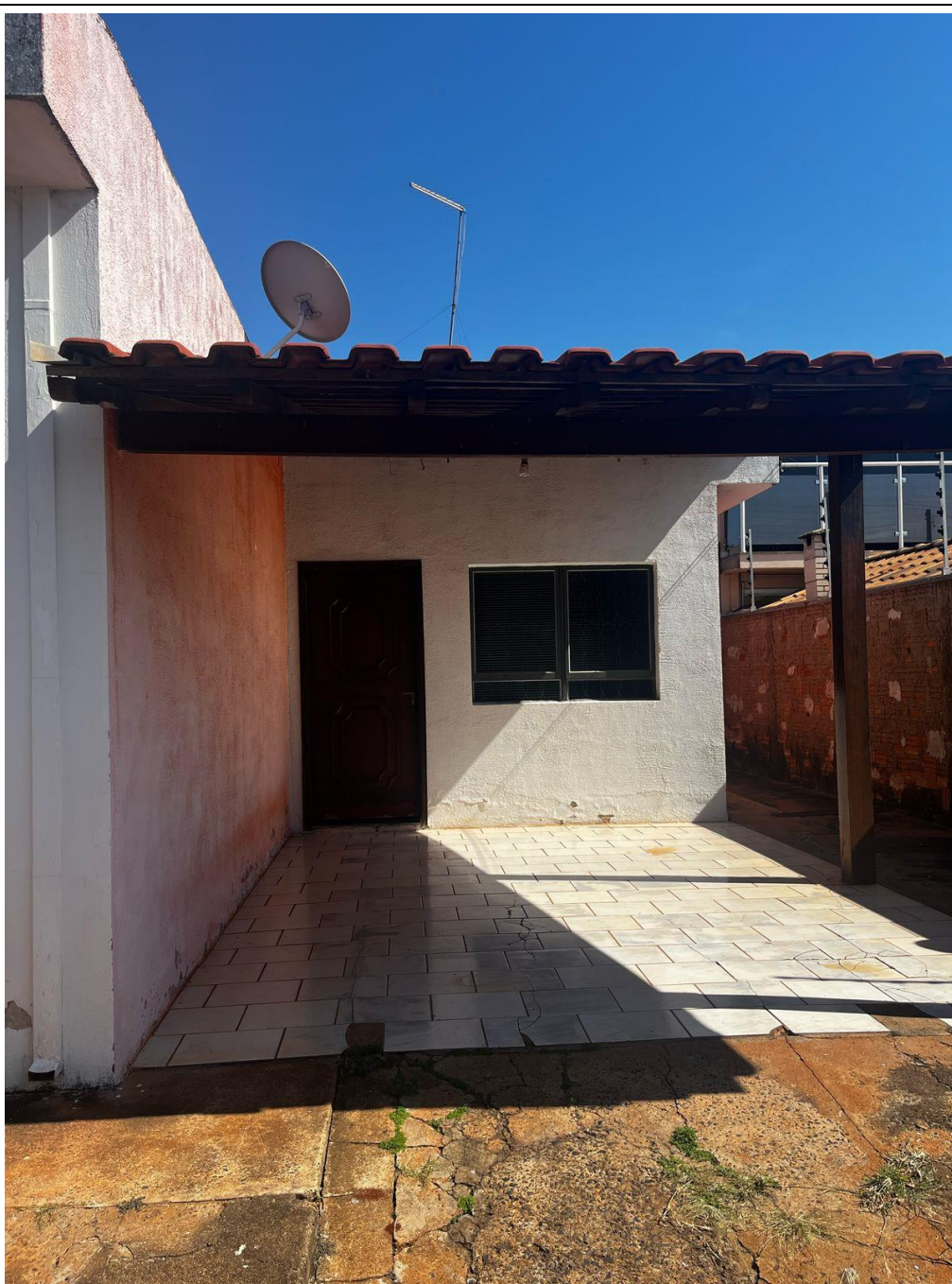
FOTO 03 – Vista parcial da parte frontal da residência. Nota-se a muro lateral sem reboco e pequenos desgastes na parte inferior da parede abaixo da janela
