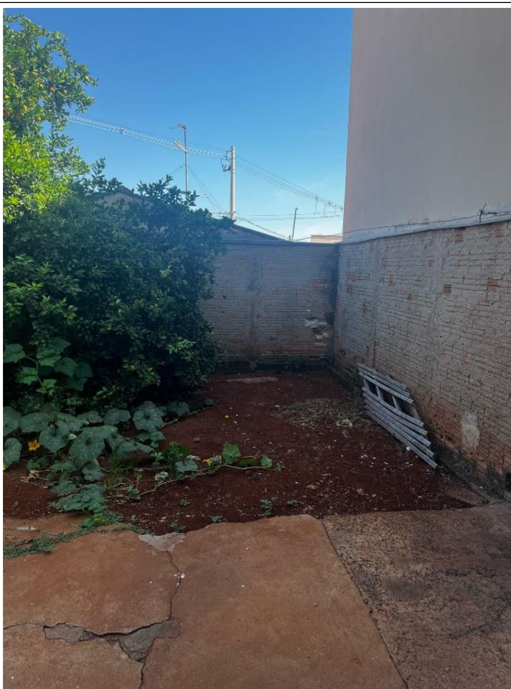
FOTO 11 – Vista parcial da área externa do imóvel.
