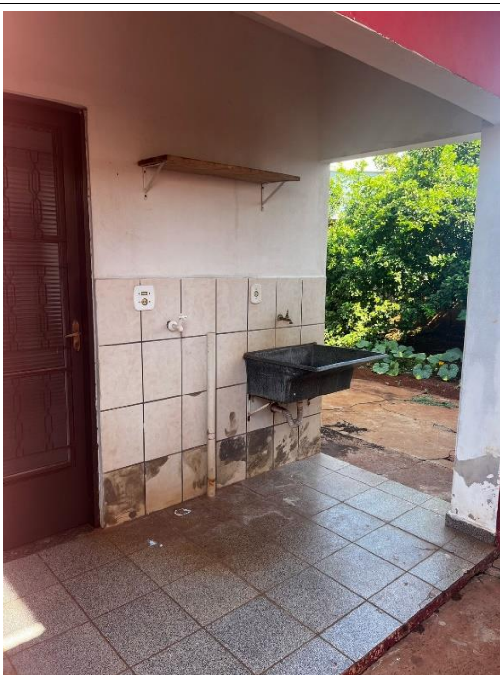
FOTO 10 – Vista parcial da lavanderia do imóvel
