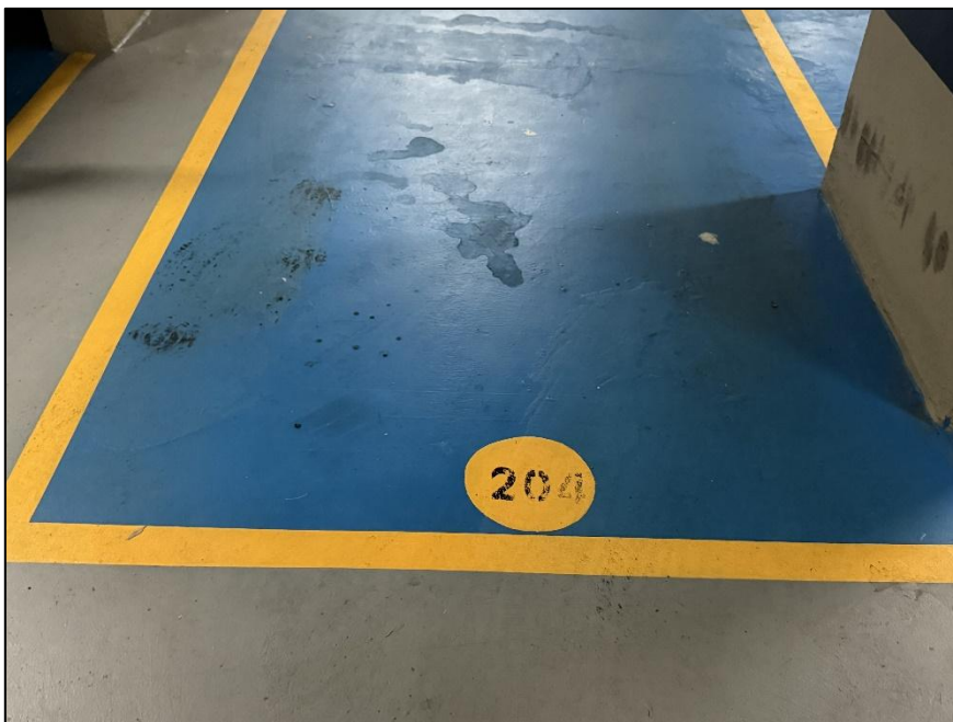
Foto 5 – Vista do detalhe da numeração da garagem.
