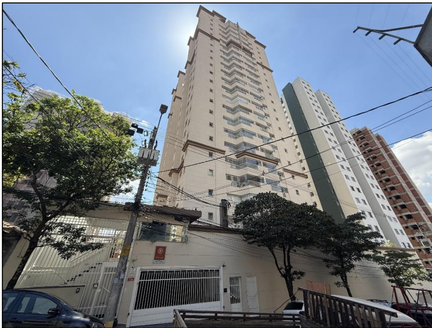
Foto 1 – Vista da fachada.
