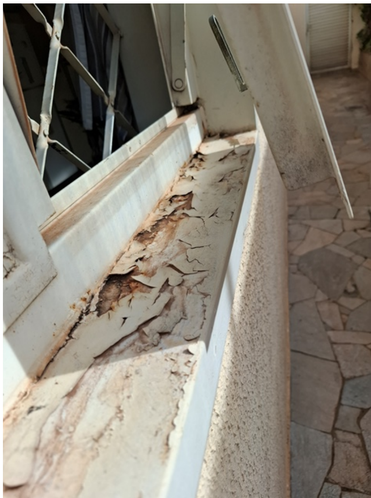
FOTO 21 – Janela com descascados na pintura e ferrugem.
