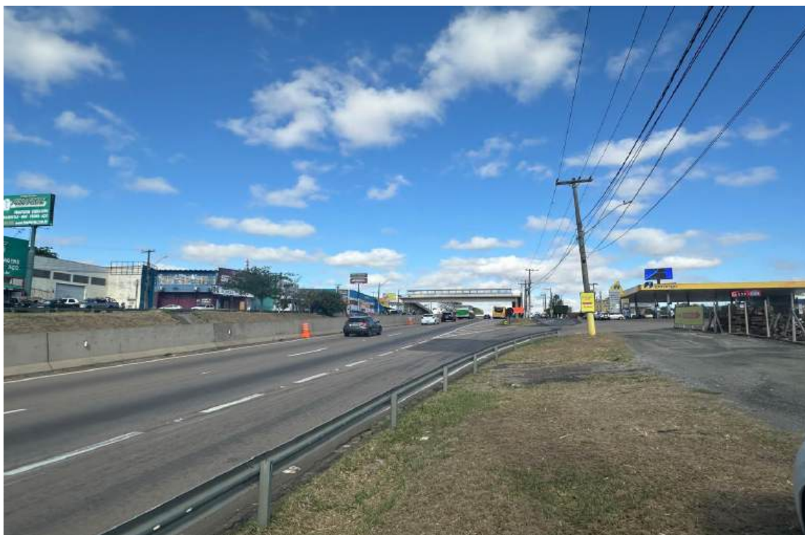
Visão da rodovia e acesso à marginal
