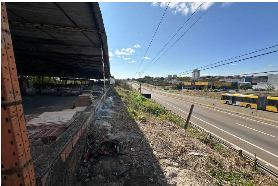
Lateral do imóvel e distância da rodovia
