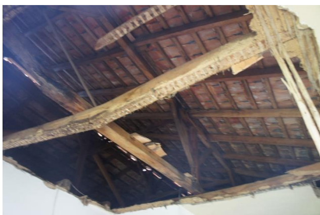
↑ Figura 14: Apodrecimento da estrutura de madeira do telhado.
