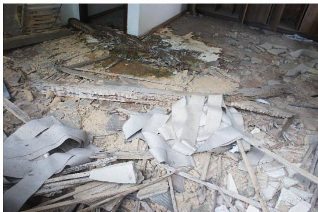
↑ Figura 13: Remanescentes de desabamento do forro do quarto.
