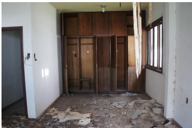
↑ Figura 12: Vista geral de um dos quartos. Observa-se retirada de pontos elétricos e remanescentes de desabamento.
