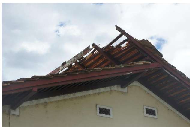
↑ Figura 15: Apodrecimento do telhado e queda de telhas.
