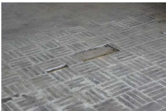
↑ Figura 16: Apodrecimento e supressão de tacos de madeira.
