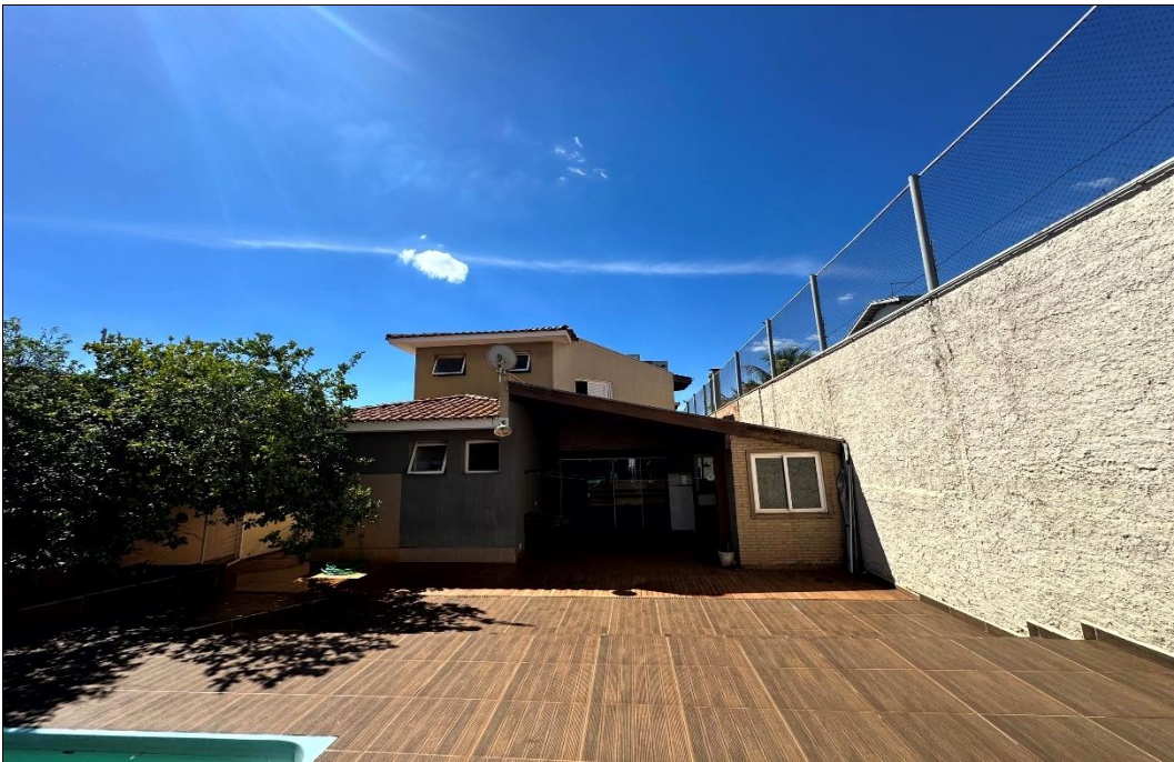
FOTO 19 – Vista geral externa da edificação avaliada.
