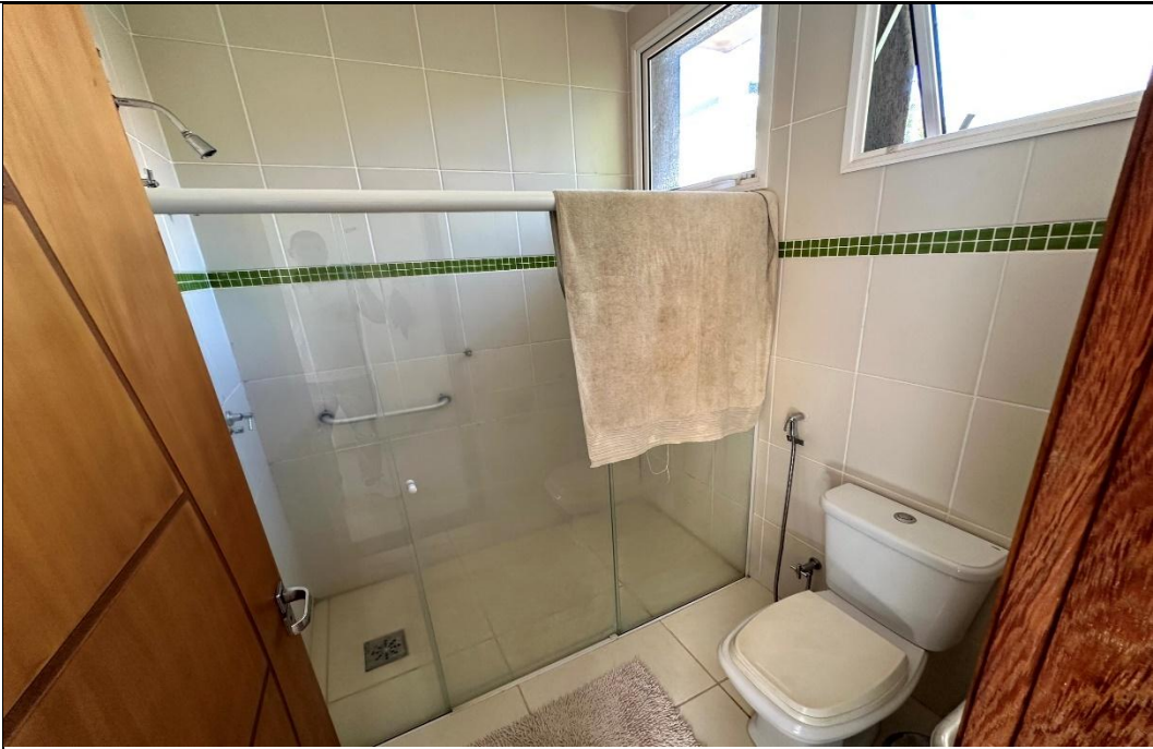
FOTO 10 – Vista geral de um dos banheiros.
