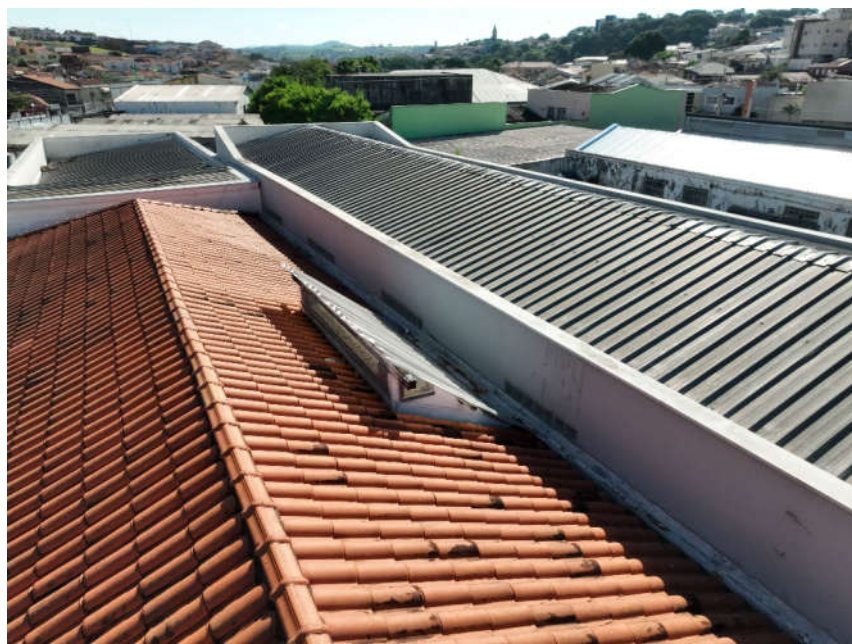
IMAGEM 24: Foto feita in loco pela equipe com drone deste perito - telhamento do imóvel 6
