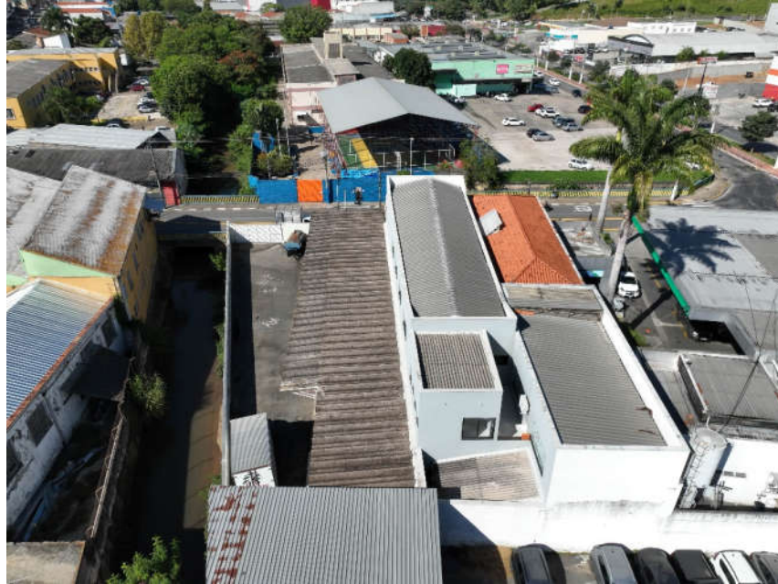
IMAGEM 21: Foto feita in loco pela equipe com drone deste perito - telhamento do imóvel 4
