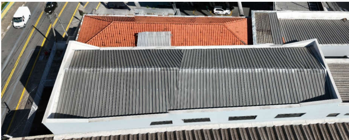
IMAGEM 22: Foto feita in loco pela equipe com drone deste perito - telhamento do imóvel 5
