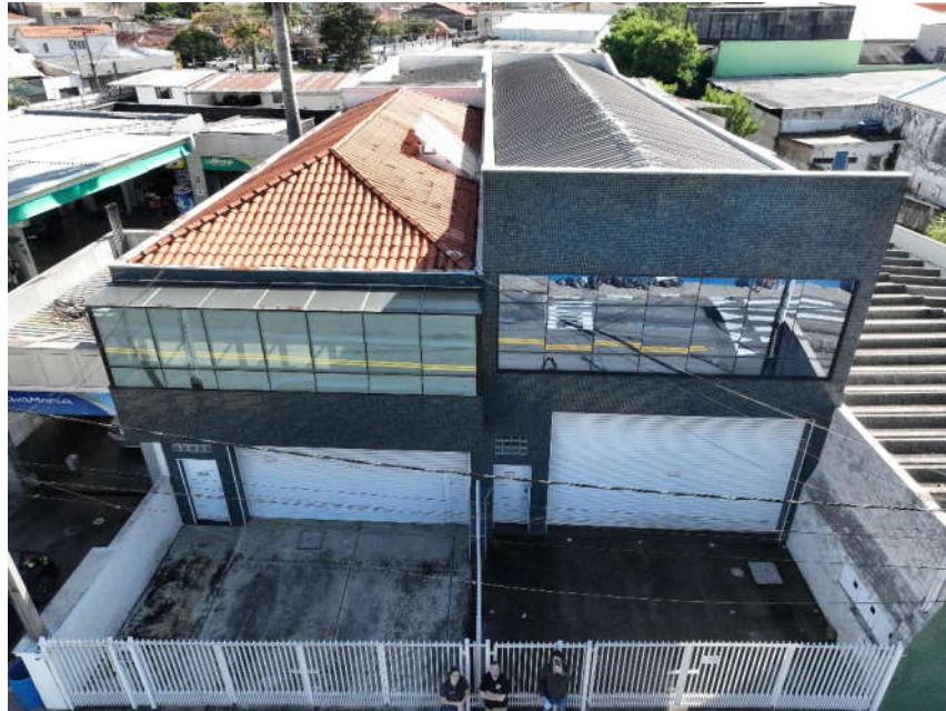
IMAGEM 11: Foto feita in loco pela equipe com drone deste perito - frente imóvel 2
