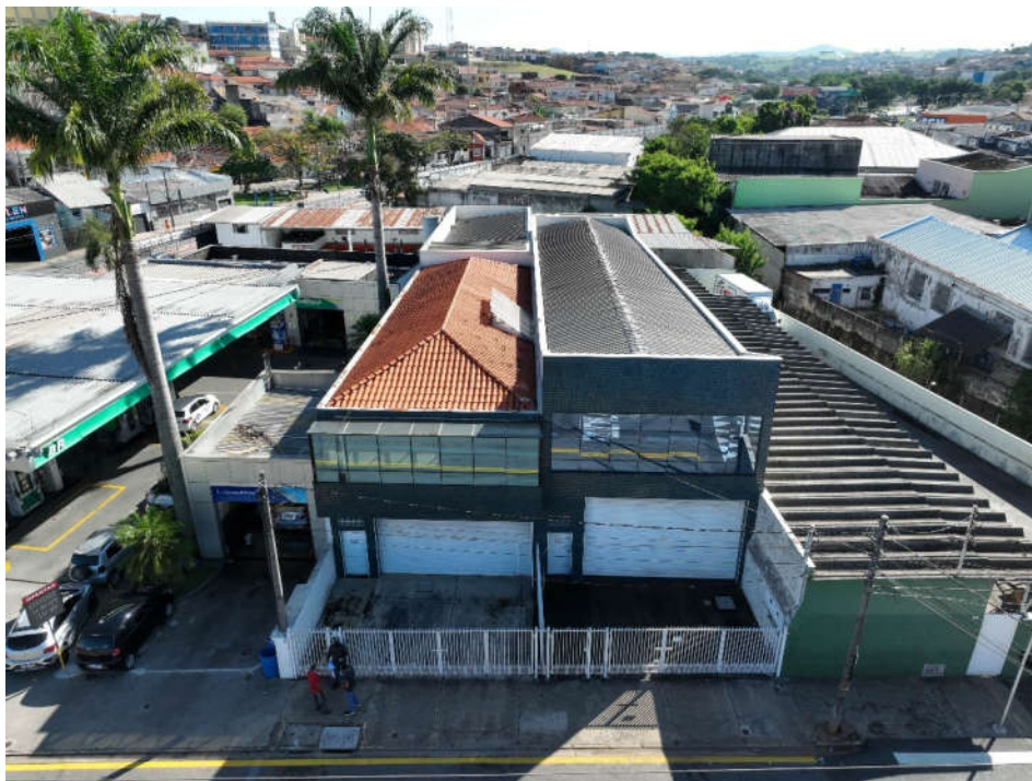
IMAGEM 10: Foto feita in loco pela equipe com drone deste perito - frente imóvel 1
