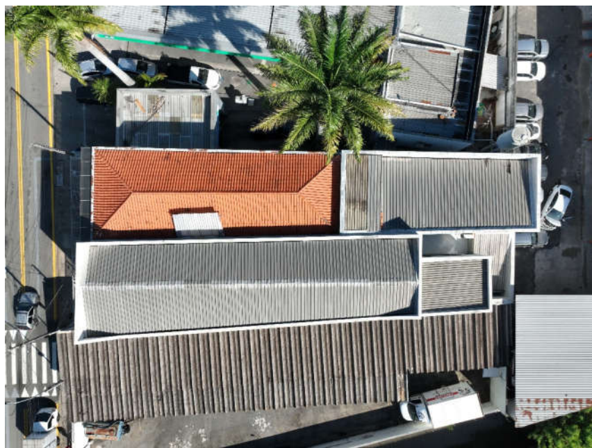
IMAGEM 18: Foto feita in loco pela equipe com drone deste perito - telhamento do imóvel 1
