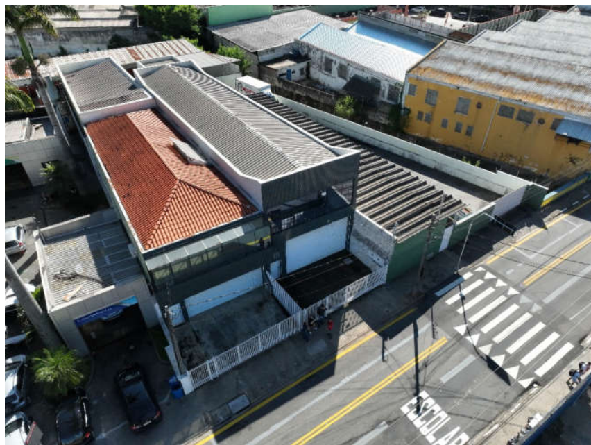
IMAGEM 15: Foto feita in loco pela equipe com drone deste perito - frente imóvel 6
