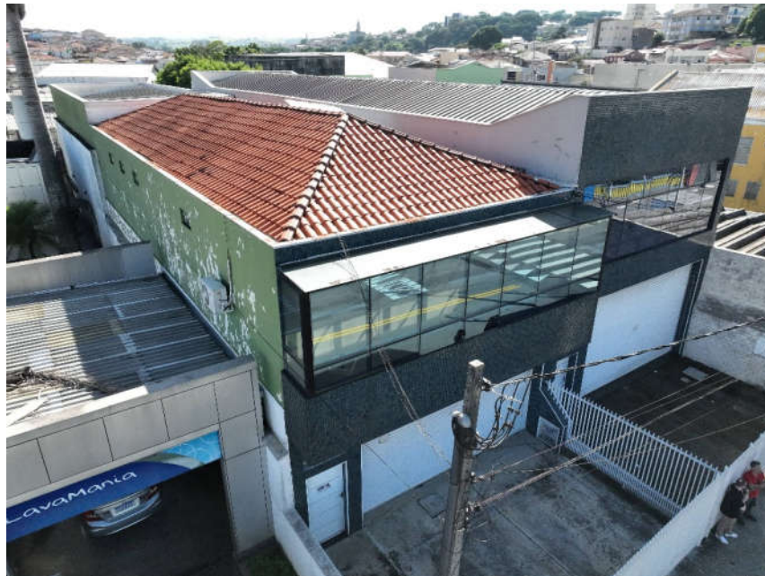
IMAGEM 14: Foto feita in loco pela equipe com drone deste perito - frente imóvel 5
