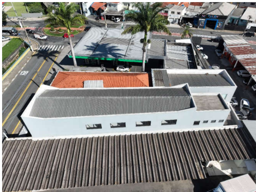
IMAGEM 17: Foto feita in loco pela equipe com drone deste perito - face leste do imóvel 2
