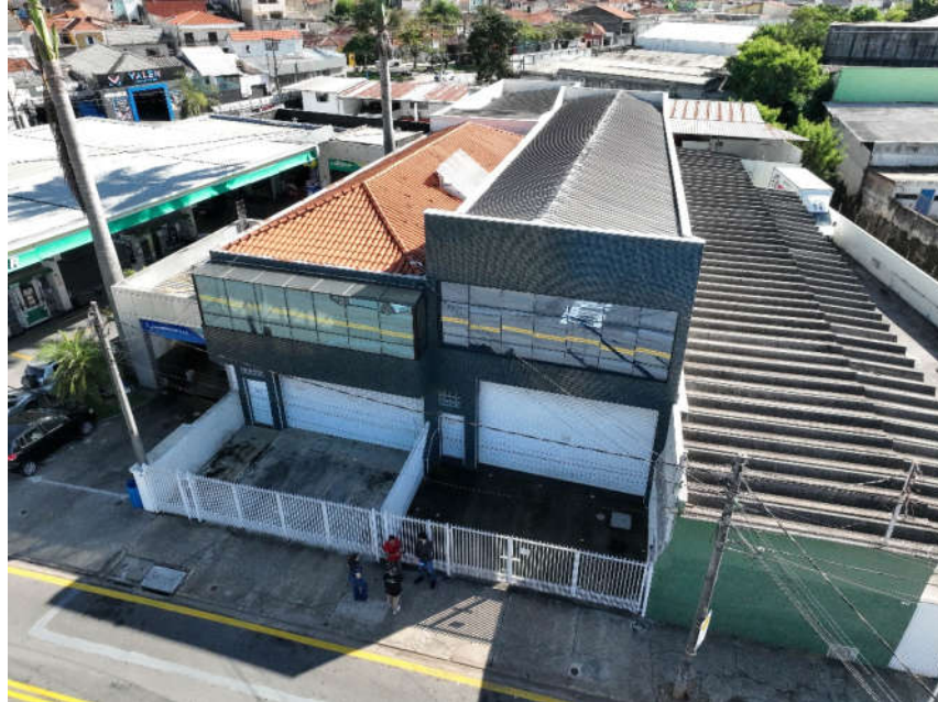
IMAGEM 13: Foto feita in loco pela equipe com drone deste perito - frente imóvel 4
