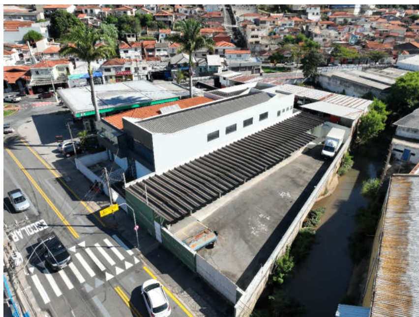
IMAGEM 16: Foto feita in loco pela equipe com drone deste perito - face leste do imóvel
