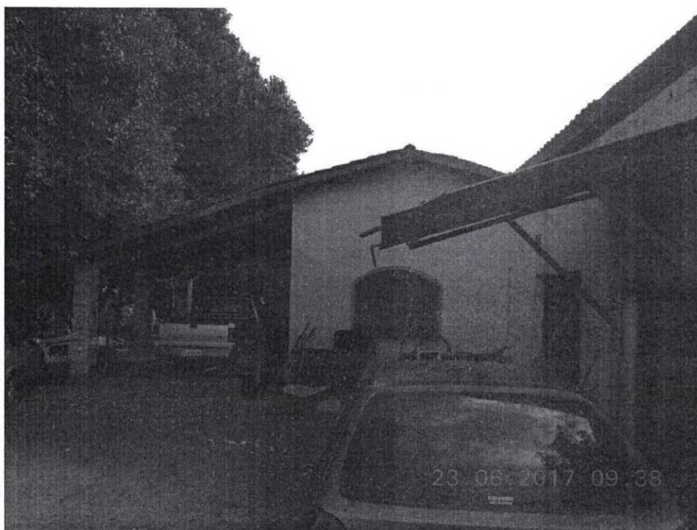
VISTAS DA CONSTRUÇÃO (RESIDÊNCIA)
